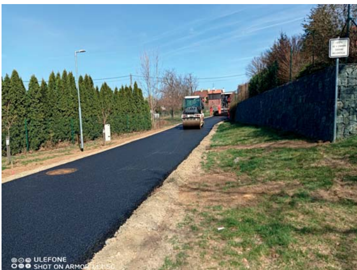
Rekonstrukce povrchu komunikace a VO na části ulice Lišky
