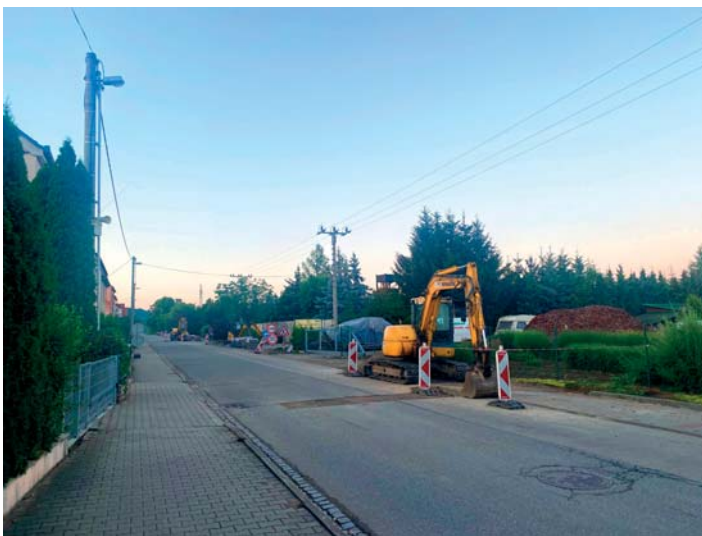
Výstavba parkovacích stání na ulici Nová
