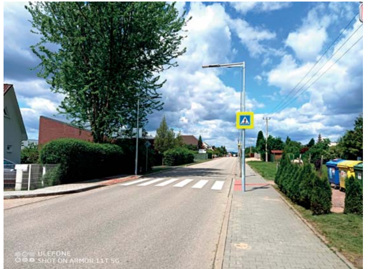
Výstavba přechodu na ulici Ostopovická
