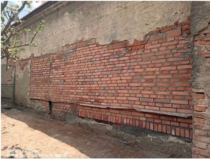
Rekonstrukce části narušeného obvodového zdiva v knihovně
