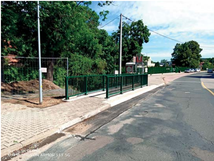
Rekonstrukce lávky X9 u budovy OÚ
