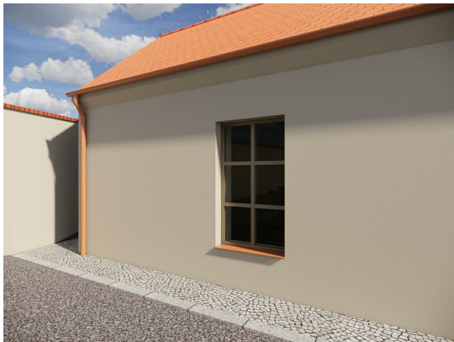
Okno v původním "kastlovém" provedení.
